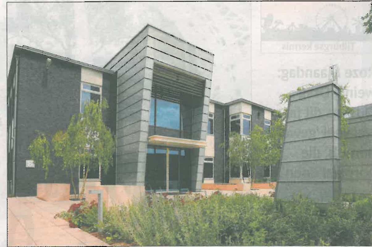
Het gebouw van Van der Heijden is energiezuinig. Voor het gebouw is zelfs een ecologische tuin aangelegd die niet geïrrigeerd hoeft te worden. Dit alles om water te besparen. foto's Edwin van Zandvoort/Photo-Prestige
